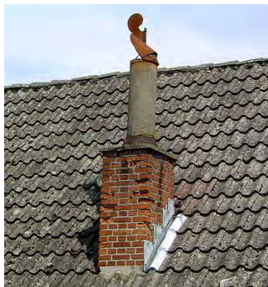
Baghus/Sidehuskorsten på tagside.
