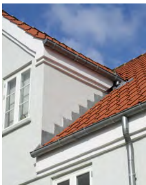
Gl. traditionel aftrappet zinkinddækning ved lodret murafgrænsning.
