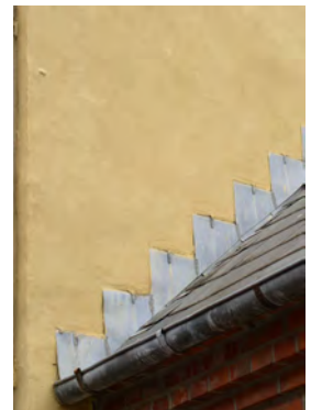
Gl. traditionel zinkinddækning ved lodret murafgrænsning. Hvor zinken aftrappes.
