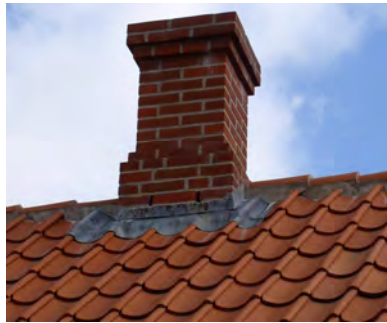
Forhuskorsten. Ribepibe med synlig blyinddækning.
